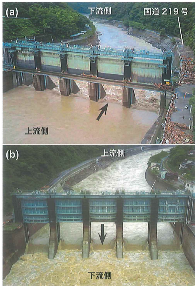
図 12 瀬戸石ダムの洪水吐ゲートを通過する際に低下する放流水の水面。(a) 上流側から、(b) 下流側から（写真提供：村山嘉昭氏，2020 年 7 月 17 日撮影） 矢印：水の流れの方向
