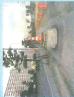
マンホールの浮き上がり（東日本大震災） 写真：独立行政法人土木研究所
