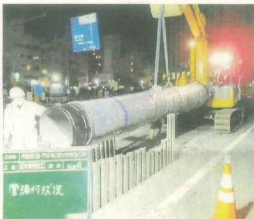
長崎市内で行われている配水管の敷設工事（2022年、長崎県市上下水道局提供）
