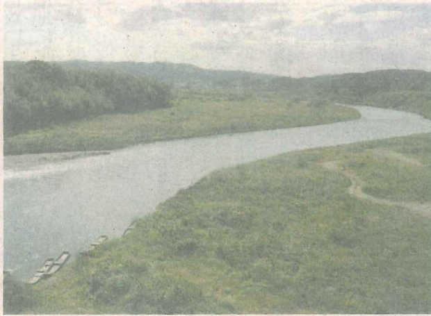
那須烏山市下境を流れる那珂川。台風19号では左に見える左岸側で浸水被害が発生した。11日午後、同所
