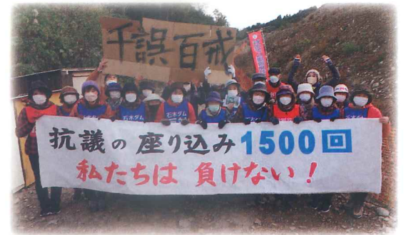
付け替え道路工事現場の中心にある抗議の座り込みテント前(2022年12月7日)
